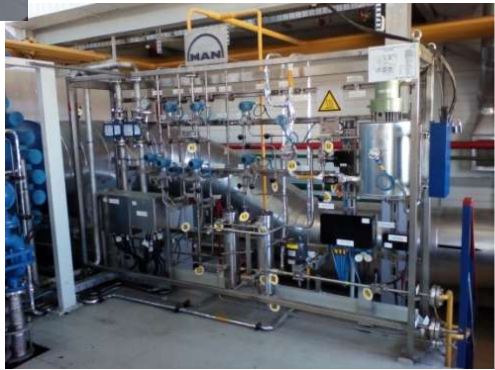
Стойка газового уплотнения
